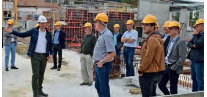
Thorsten Eberle von der Bauherrschaft (mit weissem Helm) erläuterte den Gästen den Baufortschritt. Bild: Werner Lenzin
